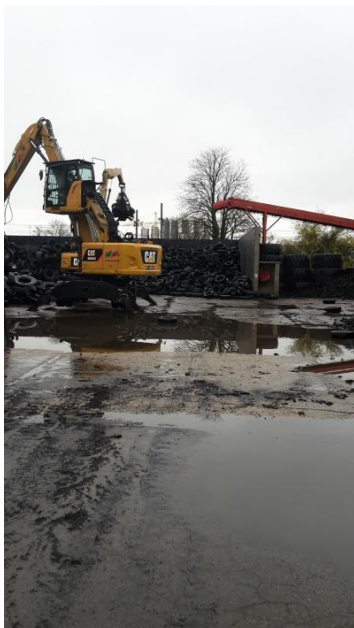
Chargement des pneus usagers par grue en vue du broyage
