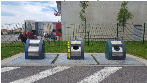
Fouille -pose en ligne
