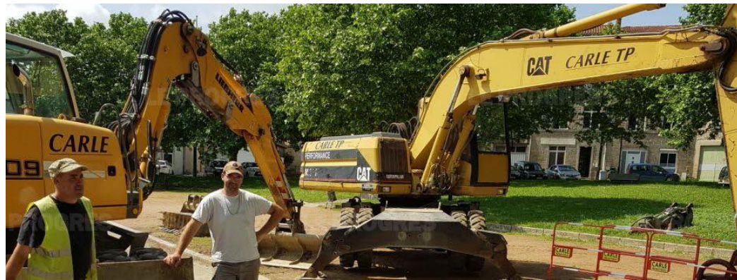
Trois nouveaux silos enterrés place de La Flette à Soucieu
